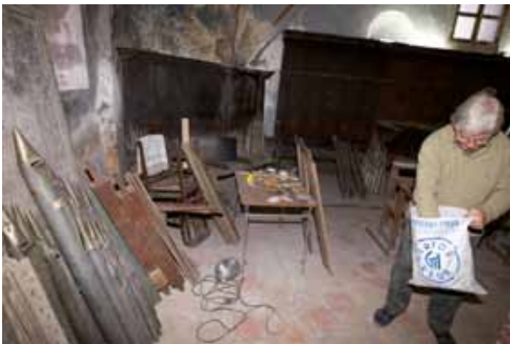
Obrador de la restauración. (Carlos Pablo)
