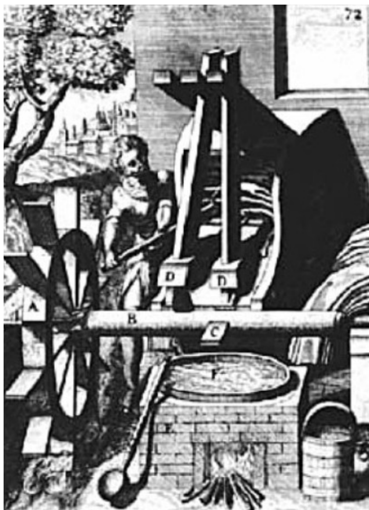
Batà segle XVII impulsat per roda vertical. (Böckler, 1997) A: roda vertical, B: arbre de leves, C: leva, D: martells.
