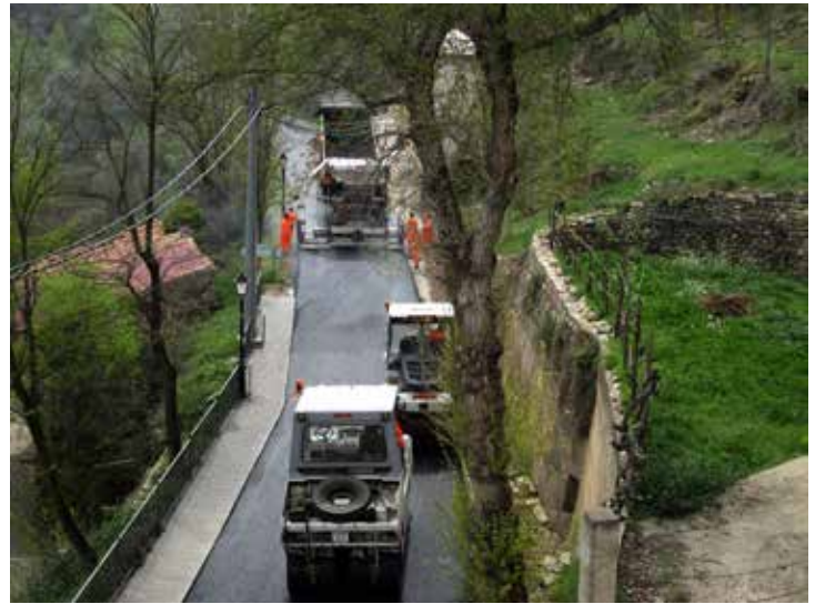
També s'ha asfaltat l'entrada del poble
