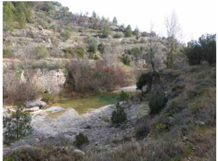
Estat actual de les restes del pont
