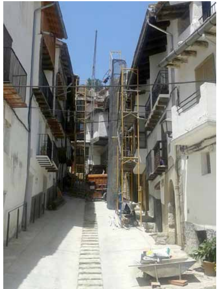
Quatre obres alhora al carrer Nou
